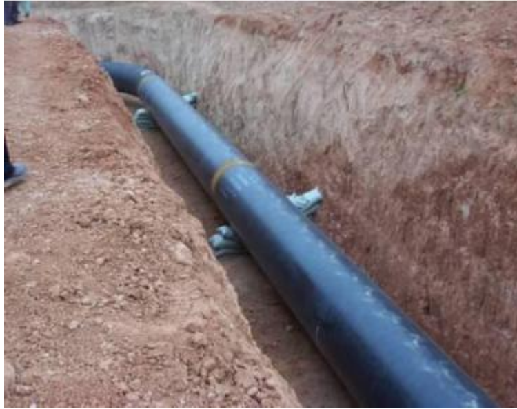
图 3.1-3 一般地段施工现场图
