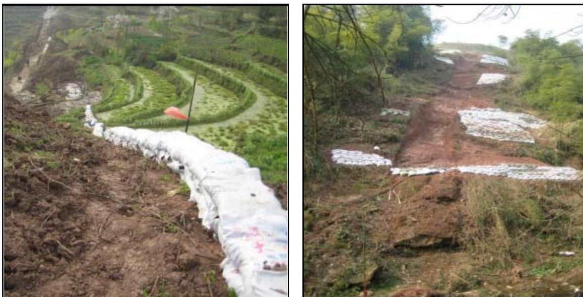
图 3.1-4 施工作业带临时水工保护措施示意图
