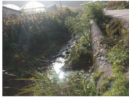
象鼻子电站压力管道周围生态恢复现状
