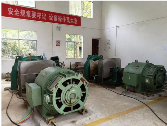
跳脚石一级电站厂房
