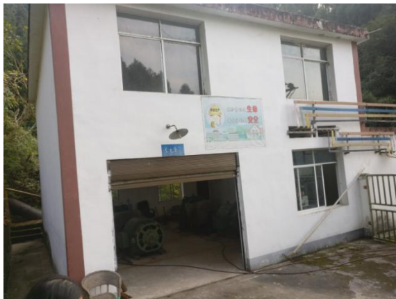
跳脚石二级电站厂房
