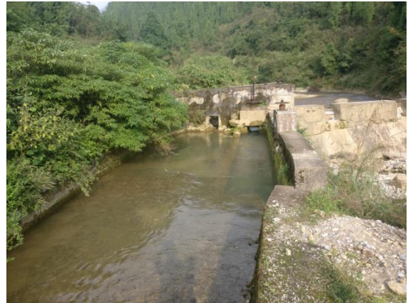
跳脚石一级电站拦水坝
