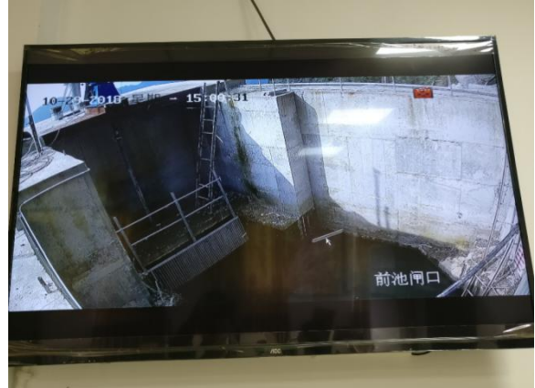
金宏电站前池
