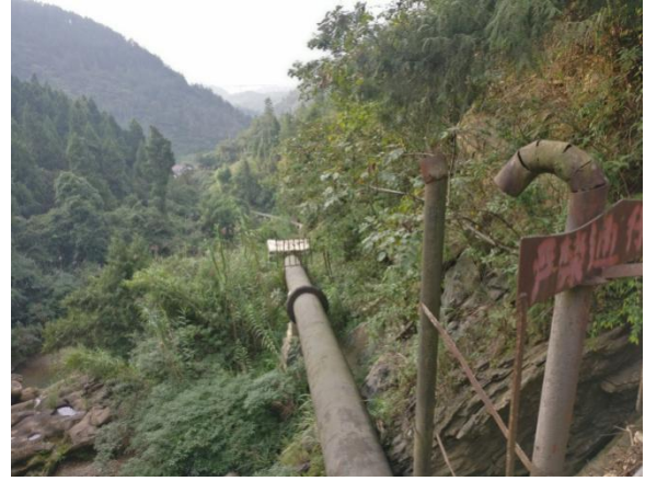
跳脚石三级电站压力管道
