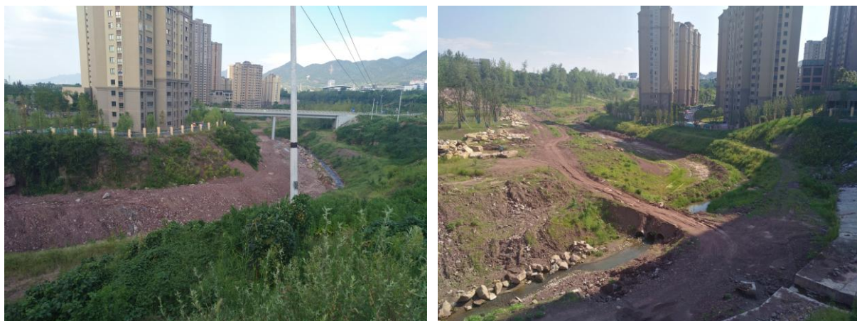
图 5.3 沿河河道整治、绿化工程
