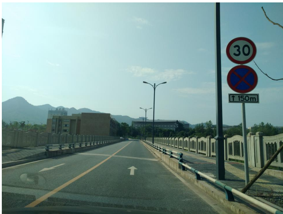
图 7.4 桥梁限速标识
