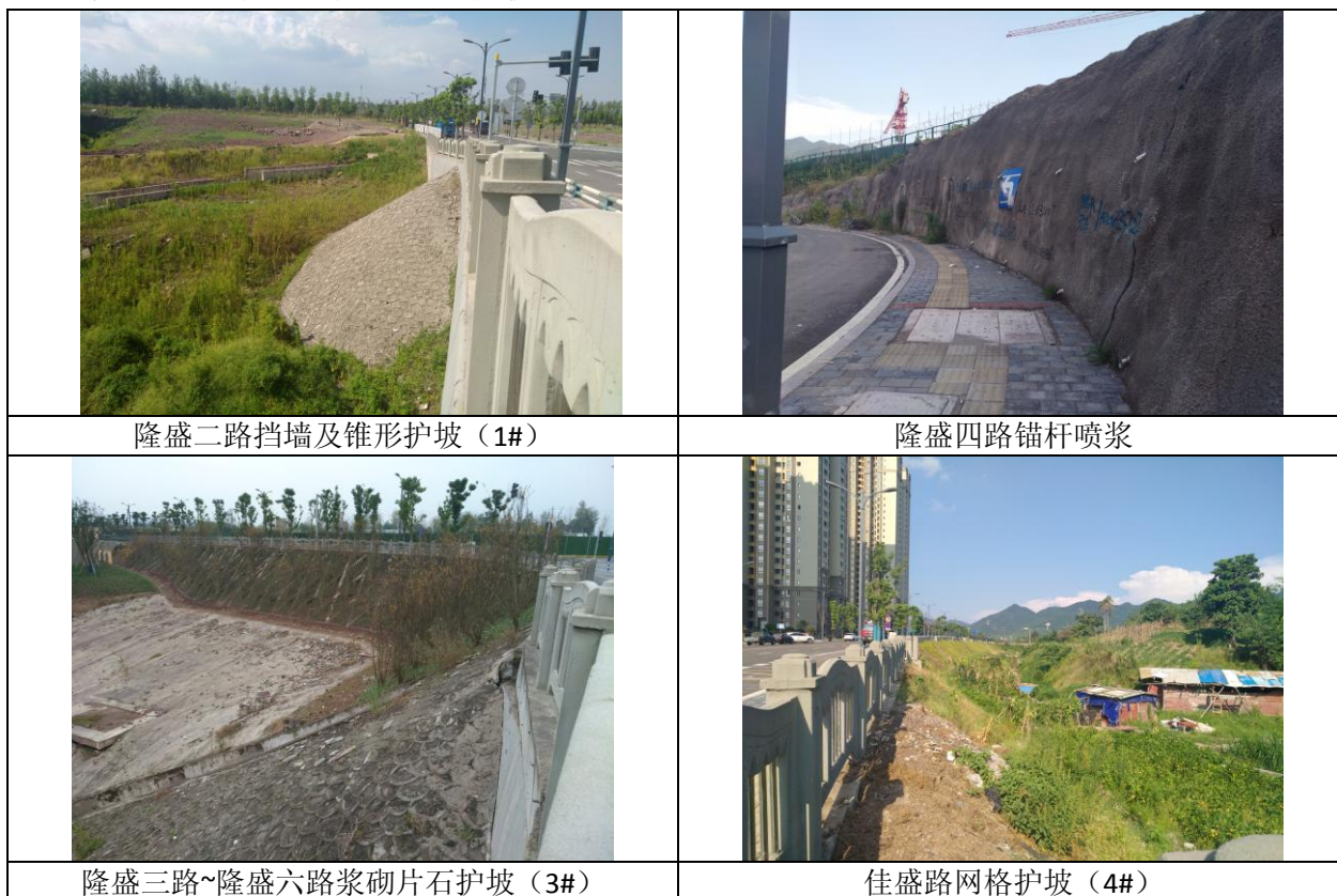
图 5.4 典型路段工程护坡
