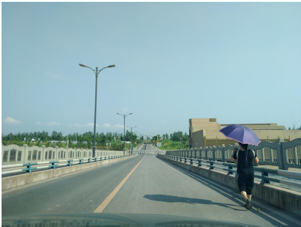
图 7.3 桥梁两侧路沿硬围挡、防撞护栏、人行护栏
