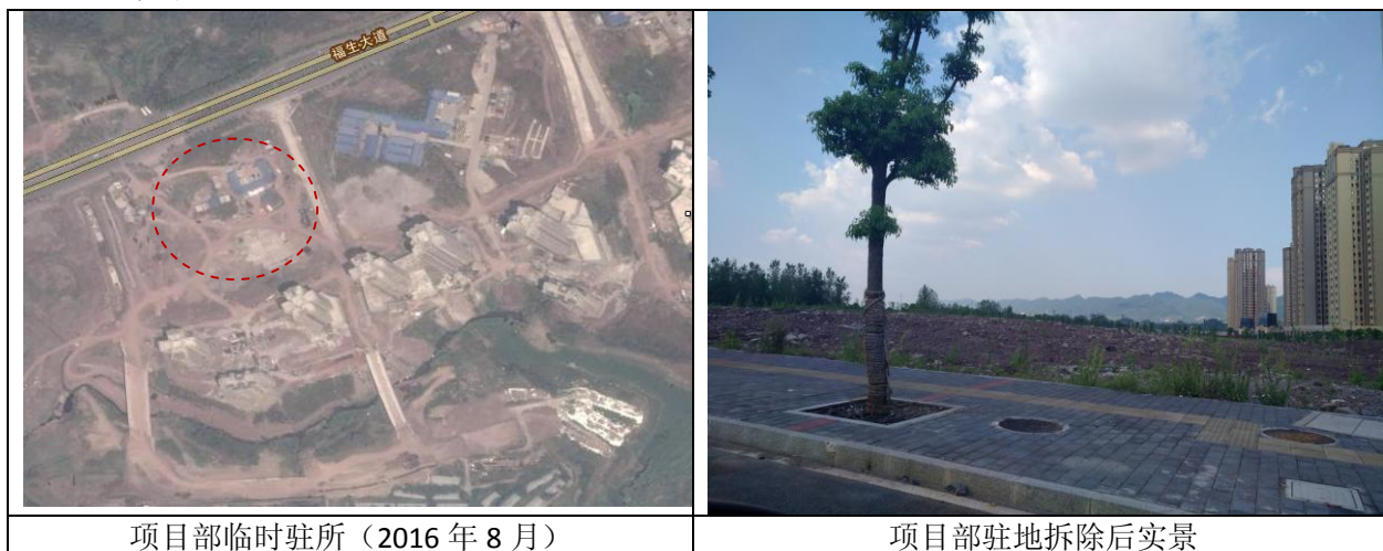
图 5.1 施工临时办公、生活营地临时占地恢复
