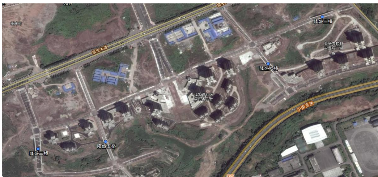
图 5.2 主体工程完工施工作业区恢复（2017 年 6 月）
